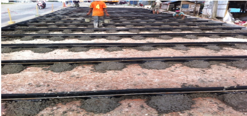
Fig.- 20 Terreno arcilloso base del pavimento de 22cm de espesor y juntas transversales
