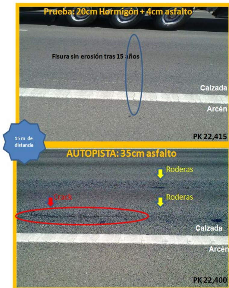
Fig.3.- Estado del firme de la autopista con 20cm de hormigón y 4cm de asfalto en zona de junta con buena transmisión
