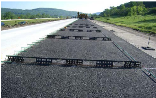
Fig.-16 Ejecución del pavimento con JRI+3 sobre base asfáltica
