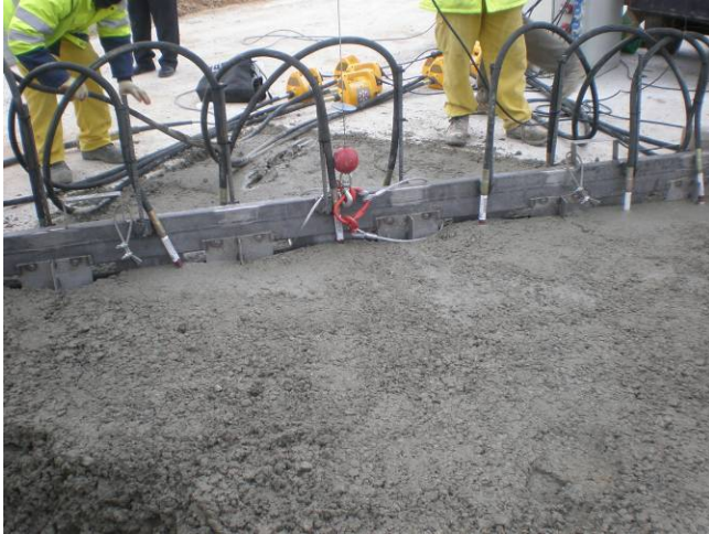
Fig. 2: Dispositivo bajado y junta JRI+4 introducida en el hormigón fresco
