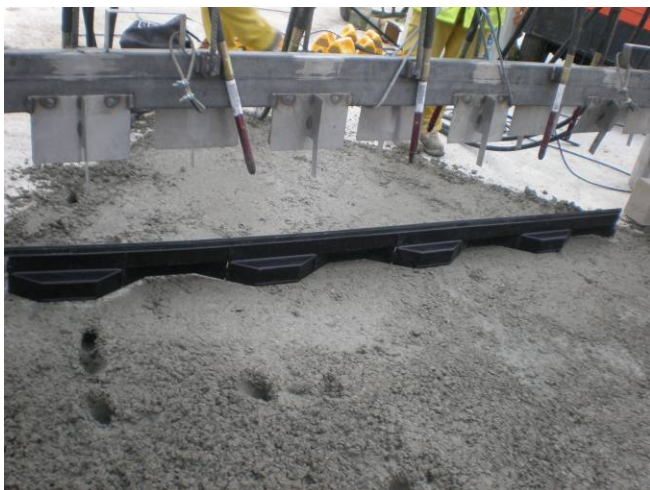
Fig. 1: Junta JRI+4 debajo del dispositivo para inserción de la junta con vibrado del hormigón
